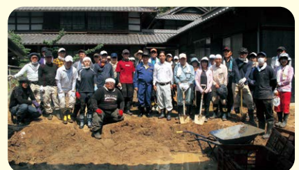
ボランティアの皆さんが必死の土砂撤去作業。(粟井・客、7/16)
